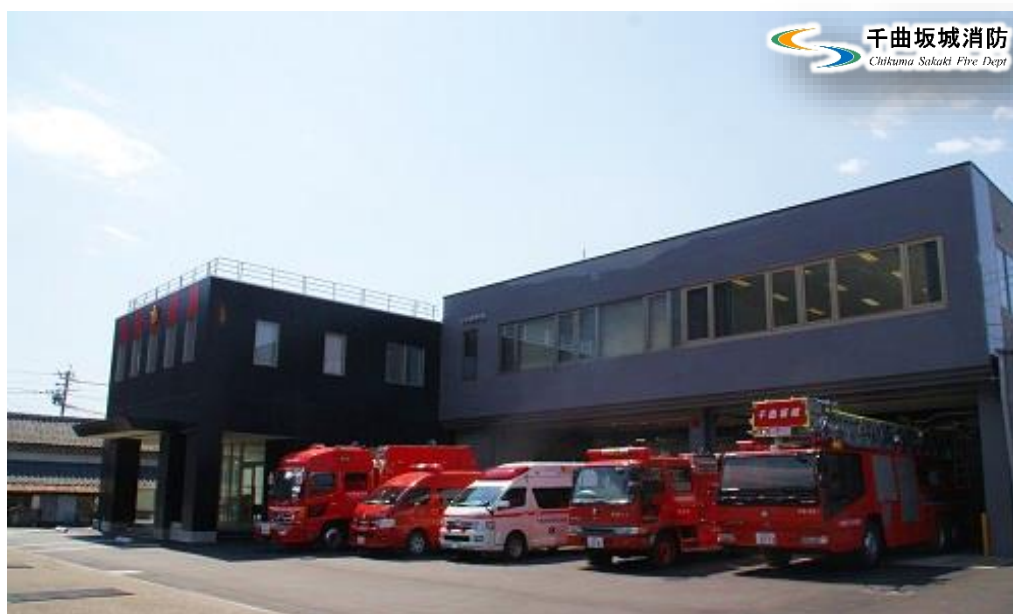
千曲坂城消防本部/戸倉上山田消防署庁舎
