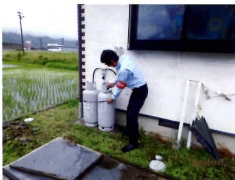
LPガスは、ガスボンベ転倒防止用の鎖が緩んでいたり位置が悪いもの、圧力調整器が古いものなど若干の問題点が数件確認されたものの概ね良好に設置されていました。ホームタンクは地震などの揺れに対する転倒防止対策（脚部固定等）や灯油が漏れ出した場合の流出防止対策（防油堤等）が施されていない家庭が見られました。
