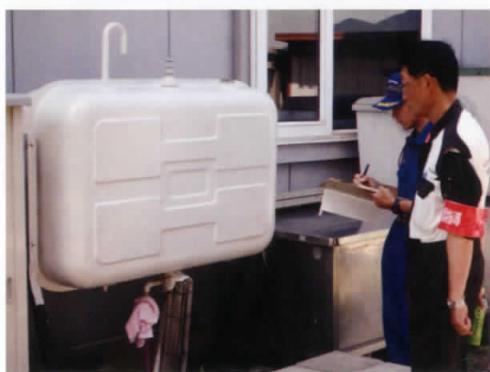
LP ガスは、ガスボンベ転倒防止用の鎖が緩んでいたり位置が悪いもの、圧力調整器が古いものなど若干の問題点が数件確認されたものの概ね良好に設置されていました。ホームタンクは地震などの揺れに対する転倒防止対策（脚部固定等）や灯油が漏れ出た場合の流出防止対策（防油堤等）が施されていない家庭が見られました。
